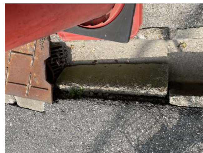
11 側溝の破損
